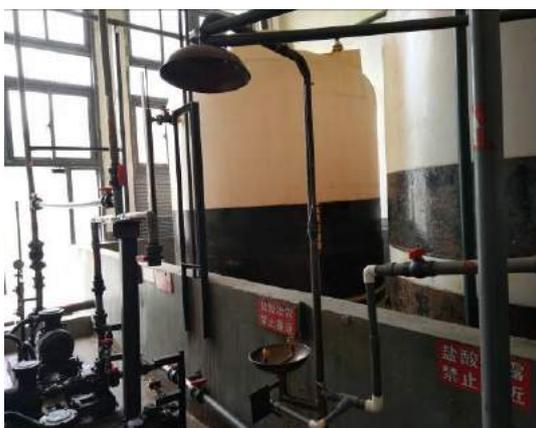
盐酸罐区的围堰、紧急喷淋装置
