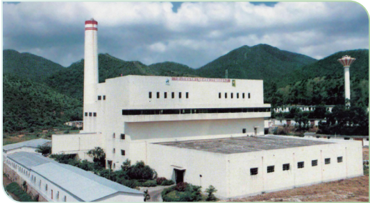
市政环卫综合处理厂建成初期全貌
