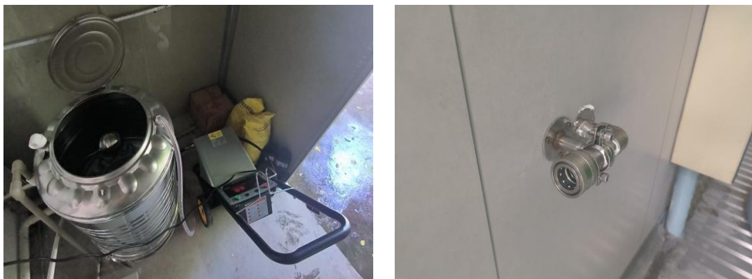
图 5-1 自动补水箱、高压清洗机与快速接头
