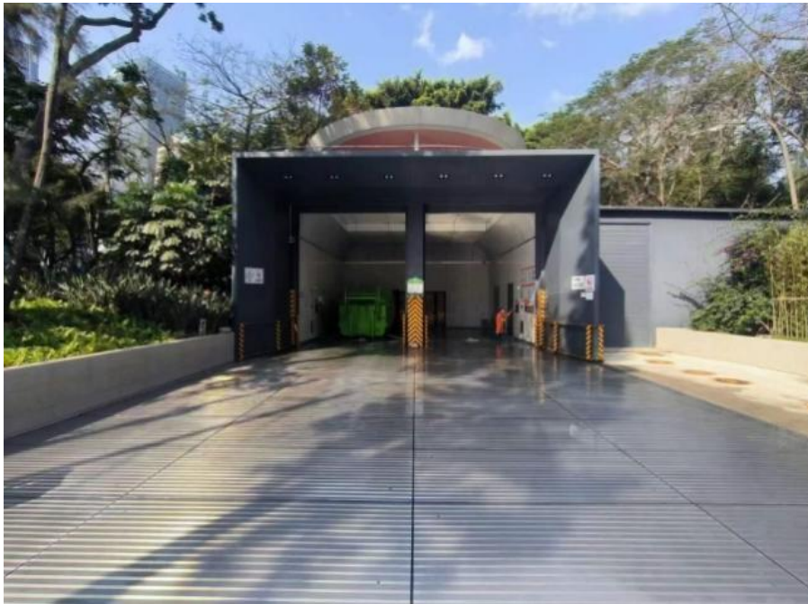
图 3-6 作业车辆回转场地拉丝不锈钢刨槽地面
