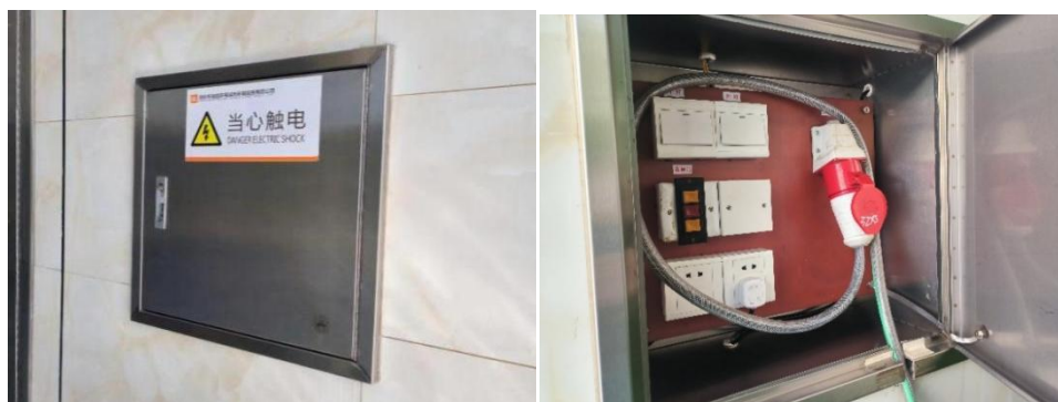
图 6-1 内嵌于墙体的独立操作电源
