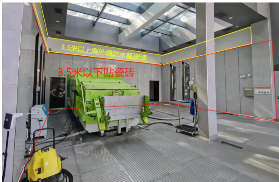
图 3-8 转运作业区内墙做法示意图
