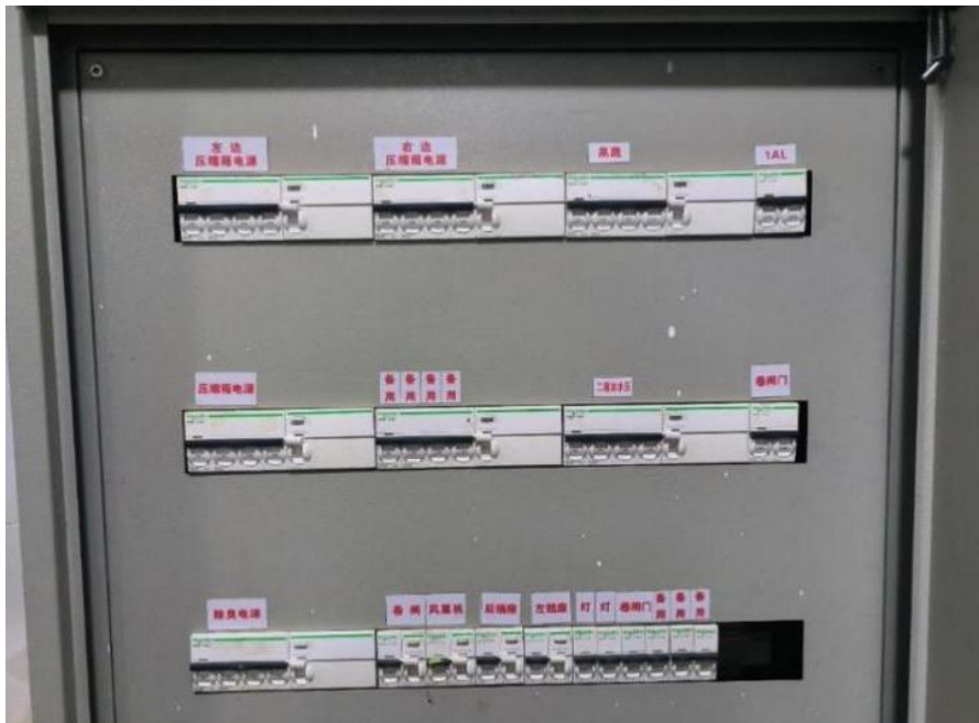
图 6-2 漏电保护装置
