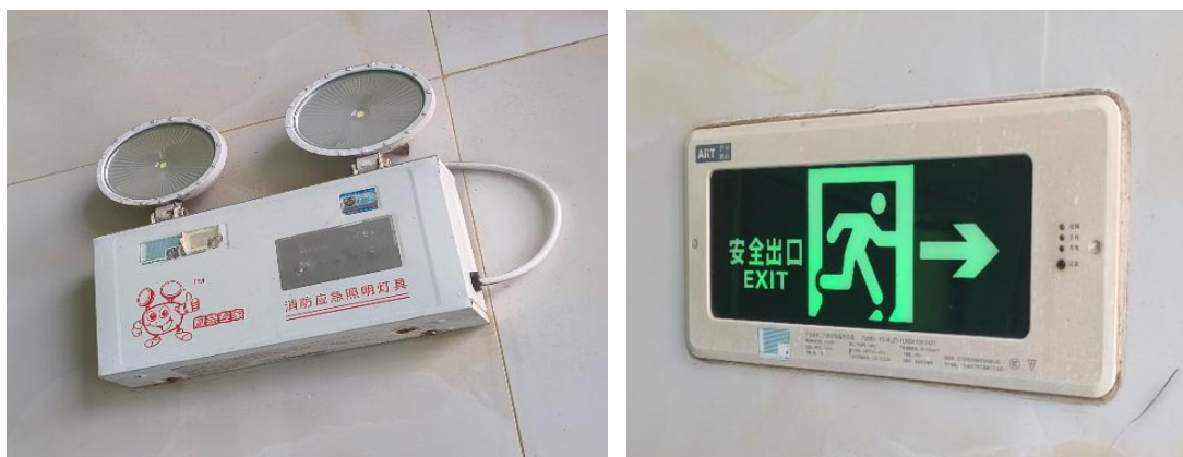
图 6-4 应急照明灯与紧急疏散通道指示灯
