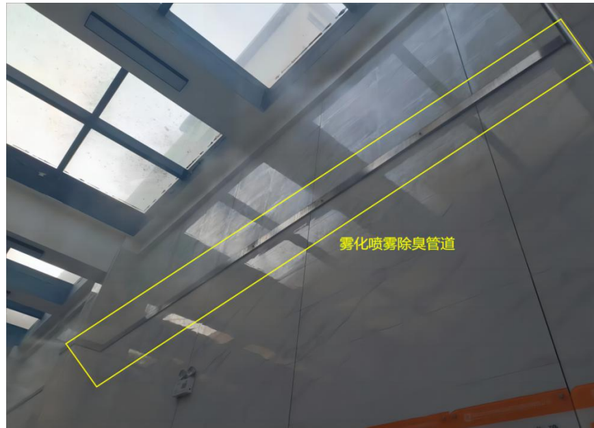
图 7-2 雾化喷淋管道
