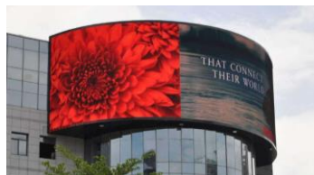
楼体整体幕墙广告
